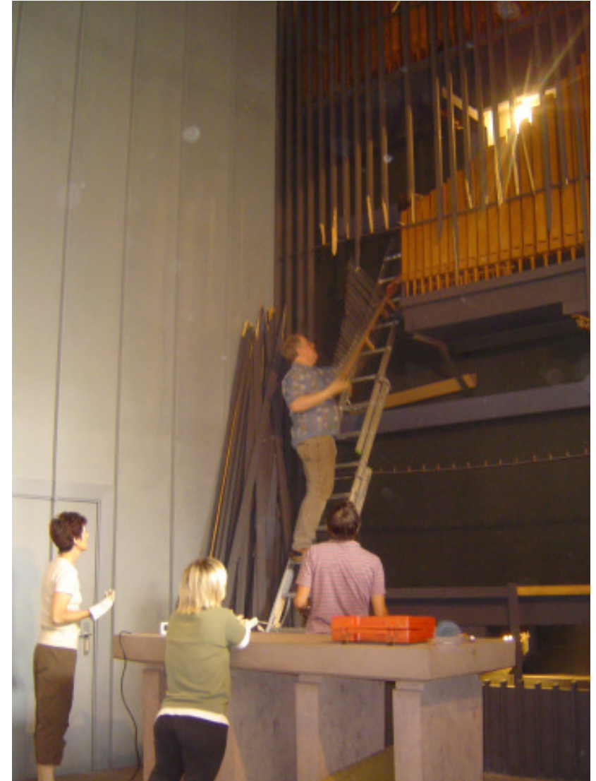
Unter Anleitung von Gerhardt Lenter werden die schweren Kegelladen des 2. Manuals in 6 Meter Höhe vorsichtig demontiert.
