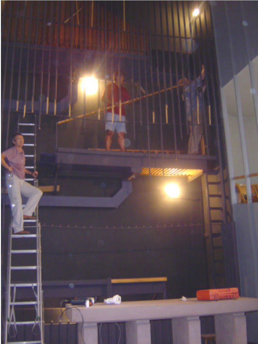
Nun werden die Holz- und Metallpfeifen des 1. Manuals abgebaut.
